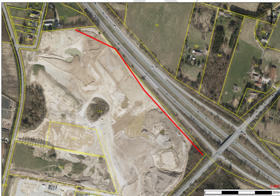
Figur 2: 2019 luftfoto. Den røde linje markerer den rørlagte strækning af det private vandløb Bøgeholmløbet, der ønskes omlagt. På det vedlagte bilag Tegning. Farremosen 26-06-2018 udarbejdet af landinspektørfirmaet Hyldegaard I/S er vandløbets nærmere placering indtegnet efter opmåling. Støjvolden og afvandingsgrøfter/-dræn etableres i samme område som er vist på luftfotoet. Støjvoldens placering i forhold til vandløbet fremgår af de vedlagte bilag med situationsplaner og oversigtsskitser. De gule streger angiver matrikelskel. Målestok er angivet i nederste højre hjørne.
